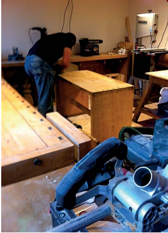
Holzwerkstatt im Haus an der Pistorinistraße, Katholischer Männerfürsorgeverein (7)
